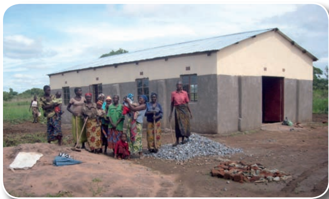
Kościół i budowa studni
