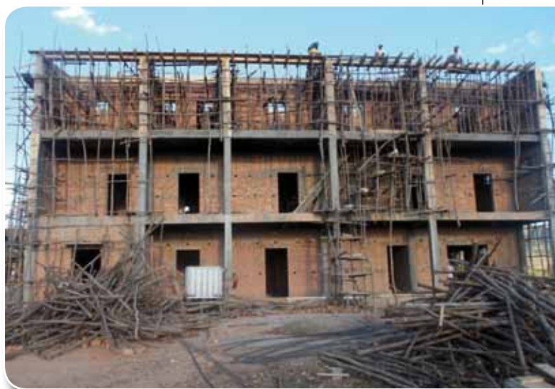
Stan budowy sierocińca w chwili obecnej (maj 2014). Wejście główne.
