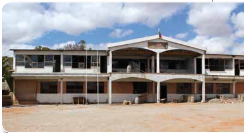
Budynek szkoły zawodowej murarsko-ciesielskiej (etap wykończenia).
