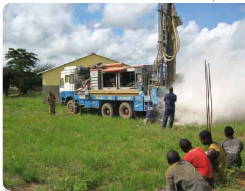
Wiercenie studni głębinowej.
