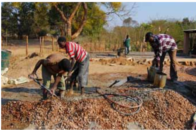
Początek budowy radiowej szkoły.
