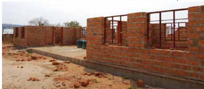
Budynek szkoły radiowej rośnie.
