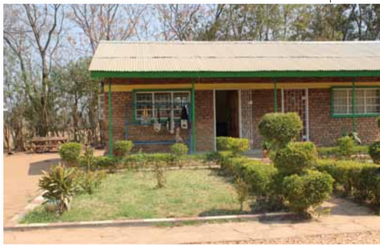
Home Base Care – projekt dla wsparcia chorych: budynek z pracownią krawiecką.
