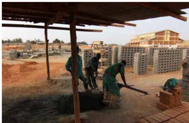
Wyrobienie cegły pod ciśnieniem.
