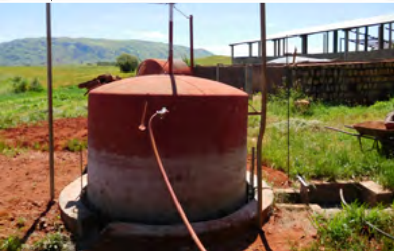
Biogazownia zbudowana przez o. Tadeusza Kasperczyka w Centrum Formacji Zawodowej w Tsiroanomandidy.
