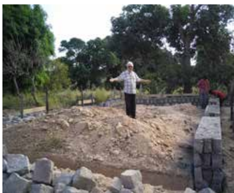
Rozpoczęcie budowy kaplicy.
