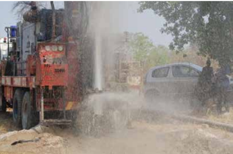
Wiercenie studni głębinowej. Maszyna borująca.
