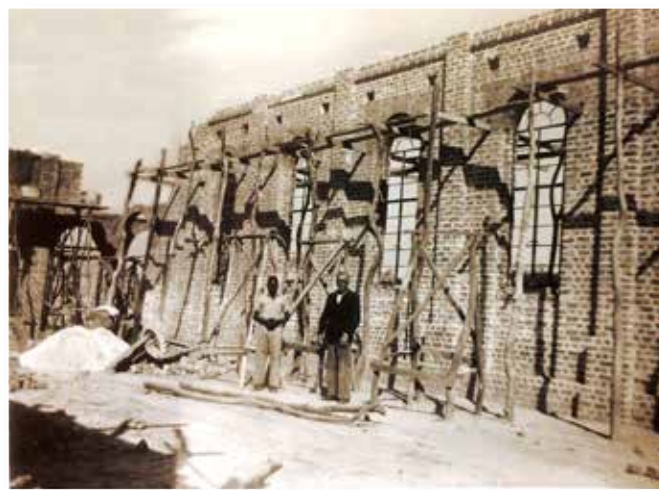
Budowa kościoła w Bwacha.
