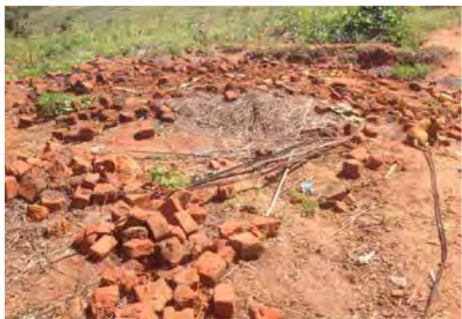
Na zdjęciach domy zniszczone przez cyklon.
