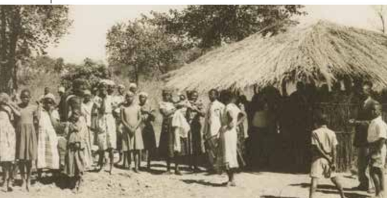
Przed chatą służącą za budynek kościoła w wiosce w drodze do Chingombe.
