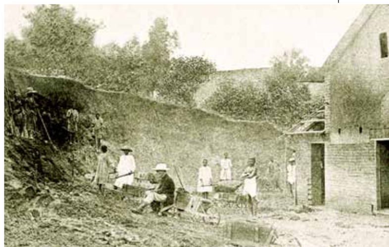
Ojciec Jan Beyzym pracuje wraz z najemnikami przy ścinaniu góry, aby zyskać więcej miejsca na szpital.
