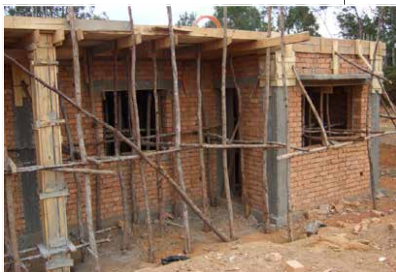
Budowa budynku administracyjnego.
