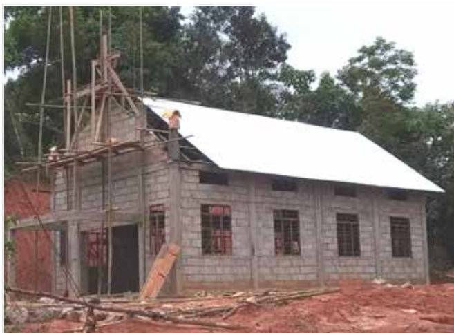
Budowa kościoła w Lawhuleng, Meghalaya, Indie, przez grupę wolontariuszy Jezuickiego Centrum Społecznego „W Akcji”.
