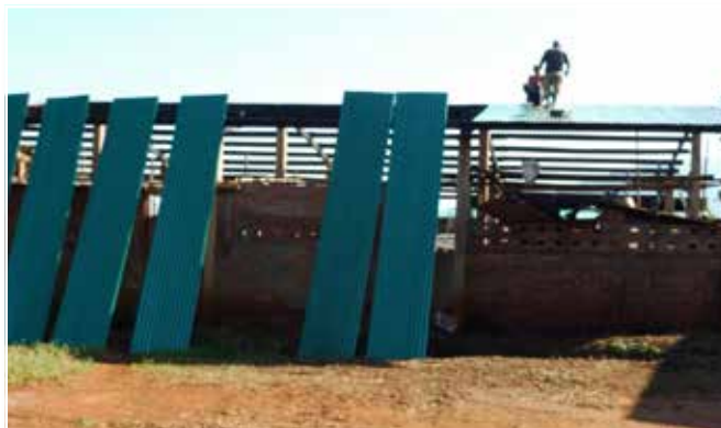
Remont dachu nad chlewnią.
