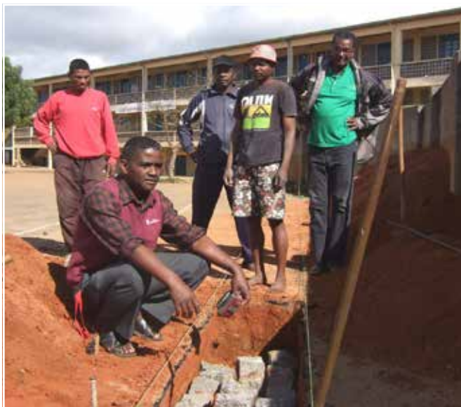
Rozpoczęcie stawiania konstrukcji budynku administracyjnego dla College'u im. św. Franciszka z Asyżu w Fianarantsoa.
