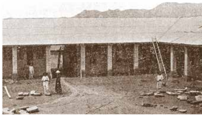
Przy budowie Marany.
