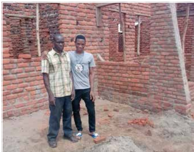
Przy budowanym domu.
