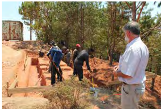
Ojciec Tadeusz nadzoruje budowę cysterny – zbiornika na wodę.
