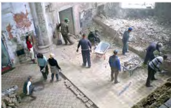
Prace wewnątrz kościoła. Porządkowanie prezbiterium na 7 dni przed jubileuszem.
