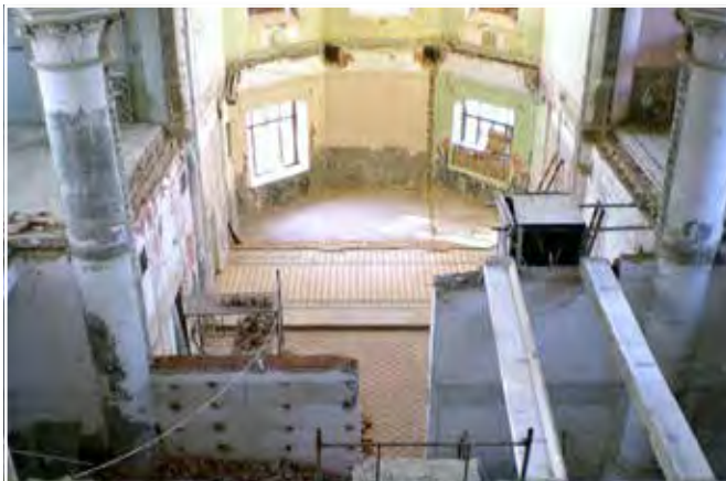
Prace wewnątrz kościoła.
