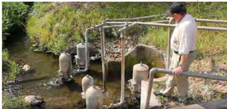
Katondwe. Taran hydrauliczny pompujący wodę do szpitala i dwóch domów zakonnych. Przed pompami o. Gerard Karas SJ, obecnie misjonarz w Malawi.
