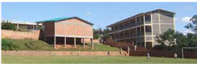
Collège św. Franciszka z Asyżu, poniżej budynków szkoły boisko szkolne.
