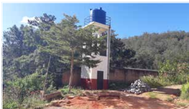
Wieża ciśnienia sieci wodociągowej dla nowo wywierconej studni głębinowej w Maranie.
