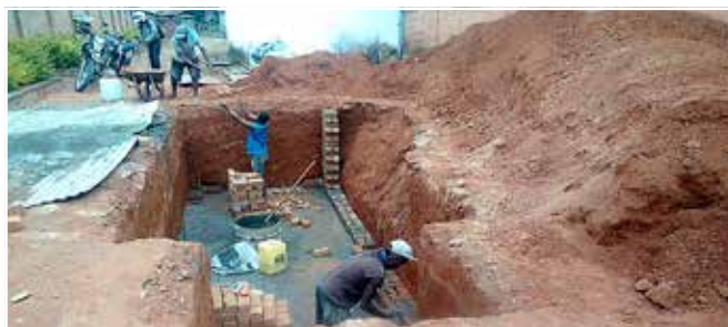
Marana, budowa fosy septycznej.
