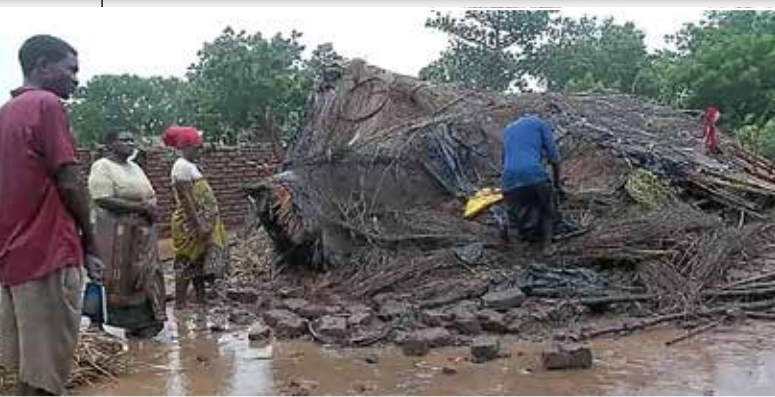
Zniszczona ulica i dom w Blantyre.
