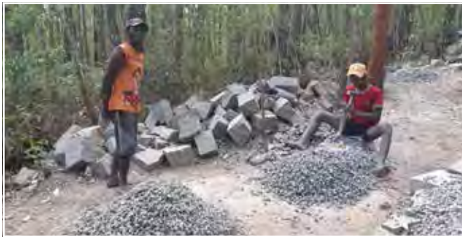
Przygotowywanie kamienia murowego łupanego (fr. moellons) ze skały granitowej, z którego zostaną położone fundamenty, oraz tłucznia do betonu.
