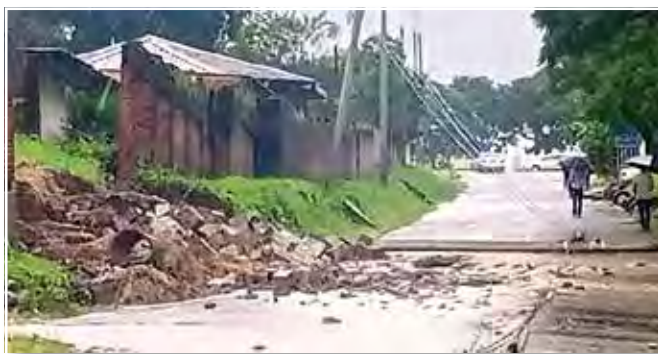
Zniszczona ulica w Blantyre.
