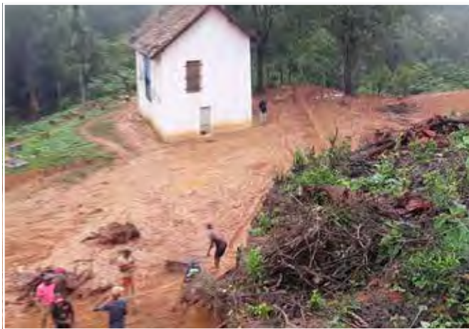
Prace wokół domku bł. Ojca Jana przy przygotowywaniu terenu pod budowę.
