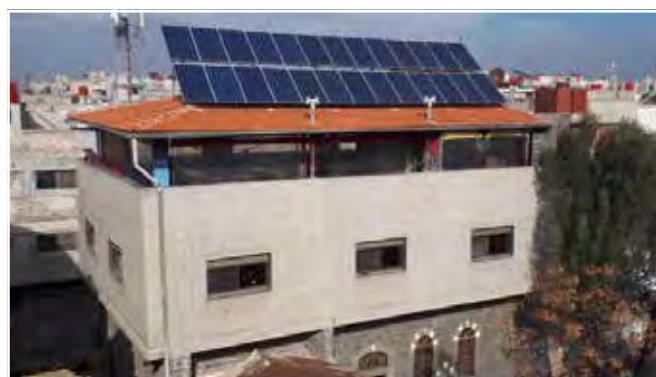
Panele fotowoltaiczne w naszym Centrum i kościele Najświętszej Maryi Panny w dzielnicy Bab as-Sbea.
