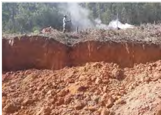
Prace przy wyrównywaniu terenu.
