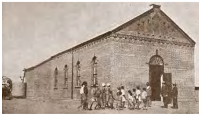
Kościół i jednocześnie szkoła w Broken Hill.
