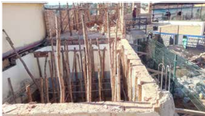
Obecny stan placu budowy.
