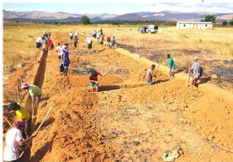
Kopanie fundamentów pod nową szkołę.
