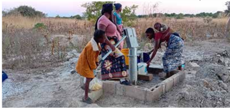
Studnia głębinowa ufundowana przez naszych Ofiarodawców.
