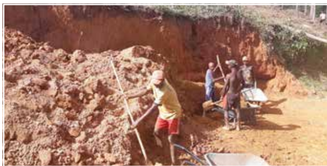
Przygotowywanie terenu pod budowę.
