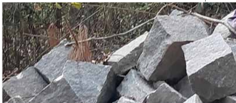
Gromadzenie materiałów na budowę. Kamień ociosany do budowy fundamentów.
