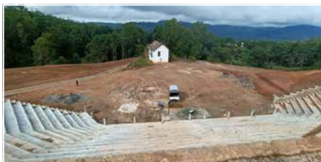
Przygotowywanie terenu pod budowę. Amfiteatr i plac pod Sanktuarium bł. Jana Beyzyma.
