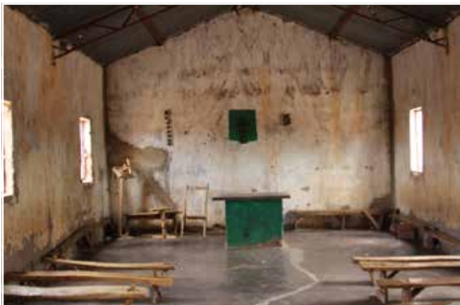
Wnętrze kościoła w Cheelo, fot. M. Szafran.
