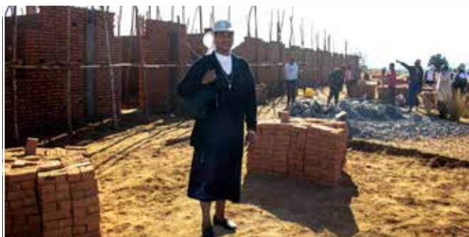
Siostra Marie Claire na placu budowy szkoły.
