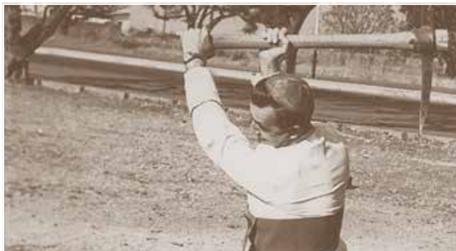
Bp Adam Kozłowiecki SJ rozpoczyna budowę domu dla episkopatu Zambii w Lusace.
