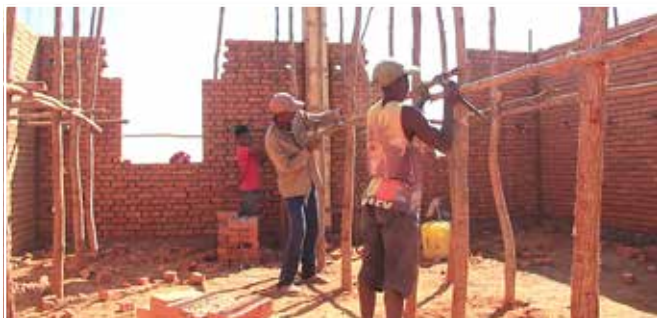
Pracownicy stawiający rusztowanie.
